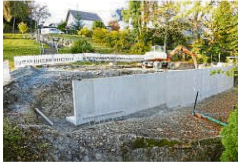
Die neue Stützmauer im Park in Schmitten nimmt langsam Gestalt an. FOTO: KREUTZ
